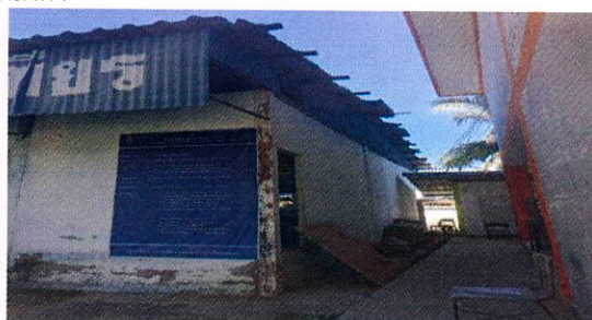
ซ่อมแซมคร่าว และโครงสร้างหลังคา
