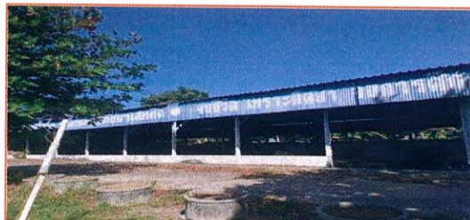
ซ่อมแซมหลังคา
